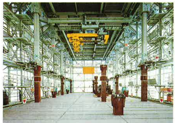
写真-2 SCF 内部
