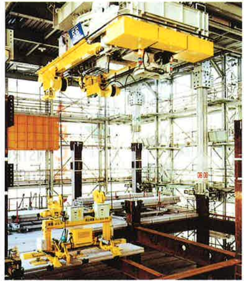
写真-4 床板敷込み
