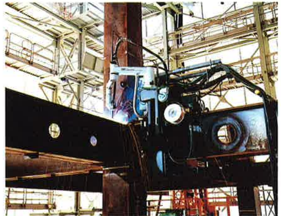
写真-6 梁用自動溶接装置
