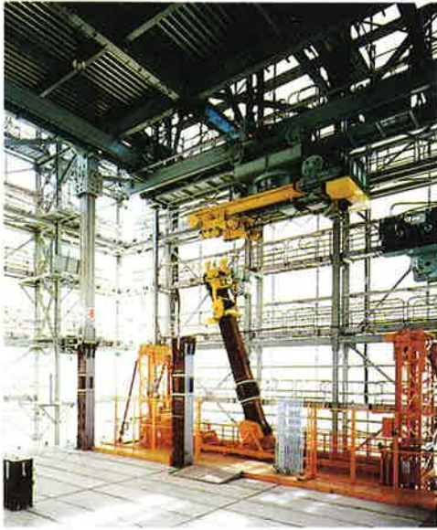
写真-3 柱建起し
