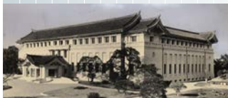
東京帝室博物館 1937年竣工
