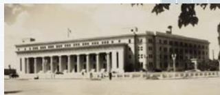
満州中央銀行 1938年竣工
