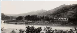
信濃川発電所 1941年竣工
