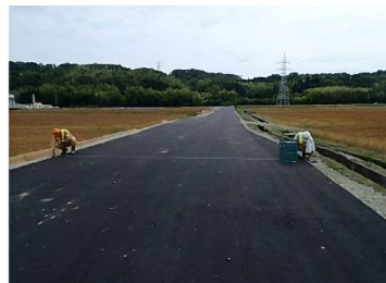
志知地区工事用道路
