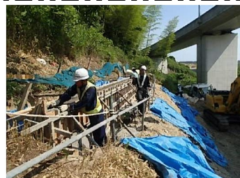
法面復旧作業
