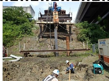
伊坂工事用仮栈橋
