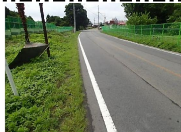
東員線ネットフェンス設置
