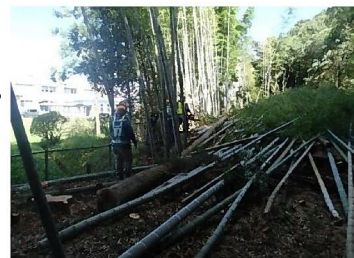
志知地区工事用道路
