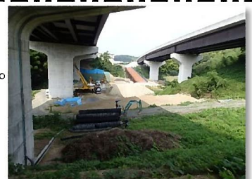
伊坂高架橋作業状
