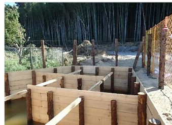
沈砂ます設置完
