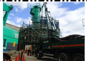
BランプP3 2LOT打設状況
