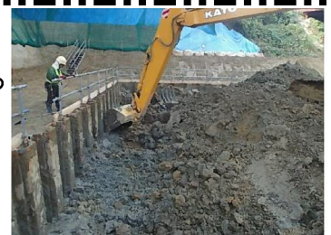
伊坂P3掘削状況
