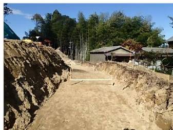
志知地区工事用道路造成
