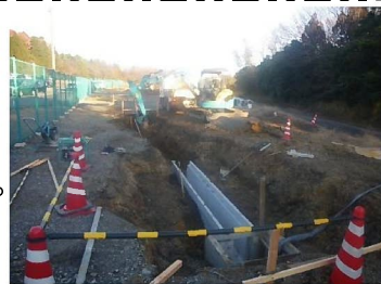
本線側道 北山付近
