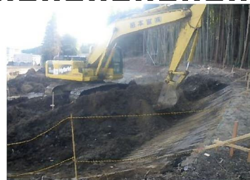
志知地区工事用道路
