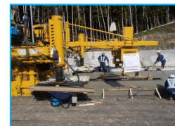
生コン車から投入されたコンクリートが平らに敷き均されて出てきます。
