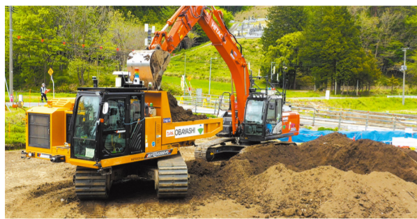
福島県飯館村長泥地区環境再生事業での自律化施工の実証状況
