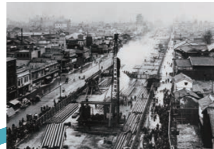
1933 大阪地下鉄（淀屋橋・北久太郎町間）
