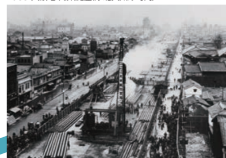
1933 大阪地下鉄（淀屋橋・北久太郎町間）
