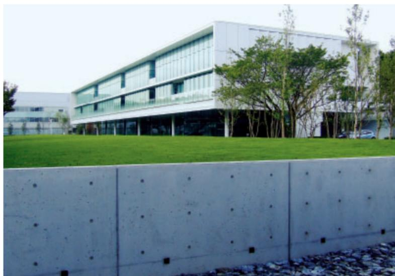
低炭素型のコンクリートを採用した擁壁。後方は技術研究所内に新しく完成した新本館「テクノステーション」
