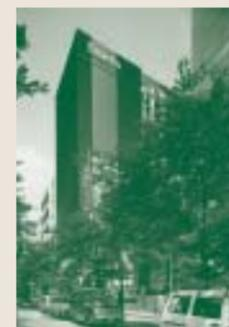
東京・八重洲でも有数の繁華街に立地し、1階は物販店舗、地下1階・地上2~8階にはダイニングバーを中心とした飲食店が入居する商業ビルです。既存地下構造体および空間を再利用することで、工期短縮・コスト削減だけでなく、建設廃棄物と二酸化炭素排出量の削減にも寄与しています。既存地下構造体を解体し、新しい地下部分を建設する場合と比較して、建物全体の構造体用資材を58%削減、資材生産時の二酸化炭素排出量に換算すると34%削減したことになりました。
