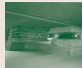
三重県本庁舎（1964年竣工）の長寿命化対策として、既存基礎の下に新たに免震層を設ける免震レトロフィットを採用しました。改修においては、建物を使用しながら工事を行うこと、免震化後の建物固有周期は4秒
