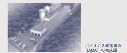
大林組は、京都府などが進める京都エコエネルギープロジェクト (NEDO技術開発機構の研究事業、通称: KEEP/キープ) の一環として、バイオガス発電施設の建設プロジェクトに参画しています。太陽光発電や風力発電は天候や時間帯によって発電量が大きく変化するので、比較的安定した電力供給が可能でバイオガス発電を組み合わせることで、電力需要に合わせ、同時時間帯に同量の電力を供給することができるシステムを目指します。今回建設する施設は、ふん尿よりもガスが多く発生する未利用有機物を利用したバイオガス発電施設です。食品工場から出る未利用有機物を、BIMA (ビマ) と呼ばれるメタン発酵槽に一日当たり64t程度投入し発酵させます。BIMAで発生したガスをガスエンジン式発電機と燃料電池に送り、最大650kWの発電を行う予定です。
