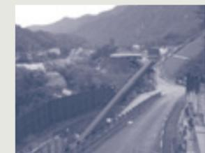
イヌワシに配慮してつや消しの緑色に塗装した防音設備で覆ったベルトコンベアと土砂置き場
