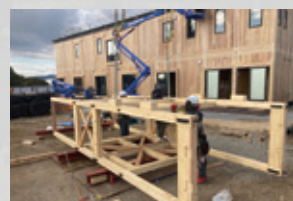
④ 外部通路ユニット地組
