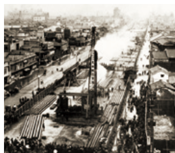
1933年 地下鉄御堂筋線 （淀屋橋－北久太郎町間） 大阪初の地下鉄となった現在の御堂筋線 工事。一帯に横たわる軟弱地盤を掘り、 河川の下をくぐるなど現代でも語り継が れるほどの難工事を実施
