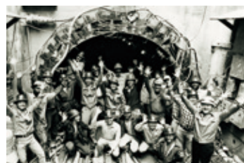
1982年 サンフランシスコ下水道 日本の建設会社として初めて米国本土で 受注した公共土木工事。米国で施工例の なかった土圧バランスシールド工法を採用
