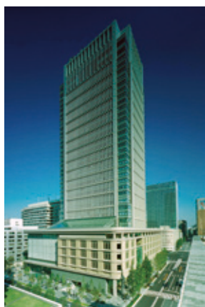
2002年 丸の内ビルディング 日本を代表するオフィスビル「丸ビル」の建 て替え工事。廃棄物ゼロミッション・モ デル現場として建設廃棄物の削減に挑戦
