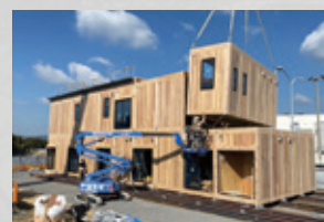
③ ユニット揚重・設置（2階部分）
