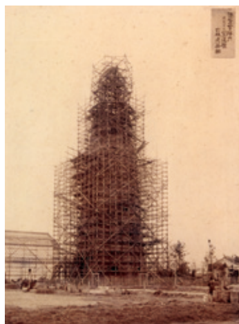
1903年 第五回内国勧業博覧会 望遠楼「大林高塔」 地上45mのエレベーター付き木造高層建築
