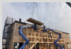
⑥ 屋根ユニット揚重・設置
