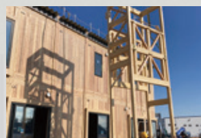
⑤ 外部通路ユニット揚重・設置
