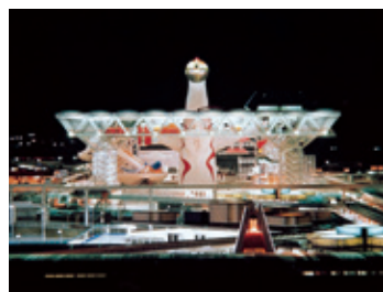
1970年 日本万国博覧会 テーマ館 アジア最初の国際博覧会。テーマ館の大 屋根のリフトアップは世界最初の試み
