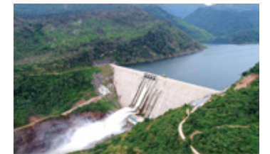
ナムニアップ1水力発電（ラオス）
