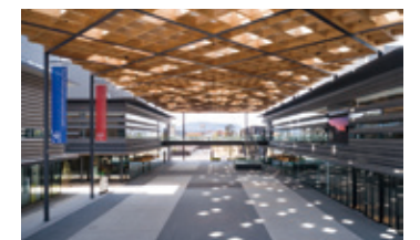
奈良県コンベンションセンター
