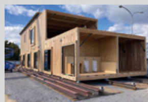
② ユニット揚重・設置
