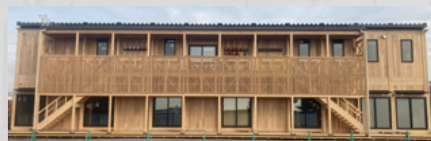
完成した木造仮設工事事務所
