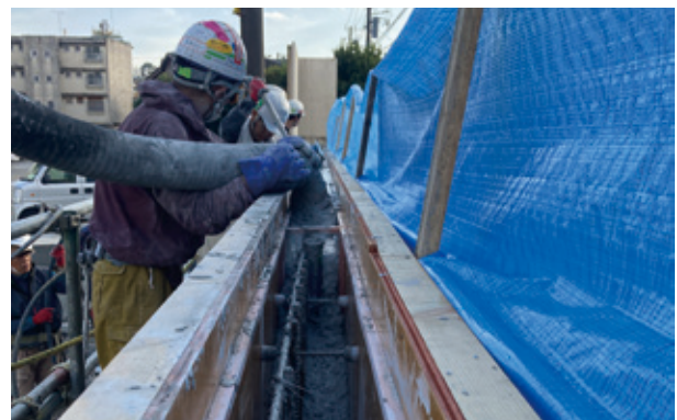
コンクリートポンプを用いた打設状況
