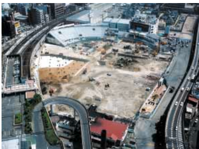
施工中の様子
