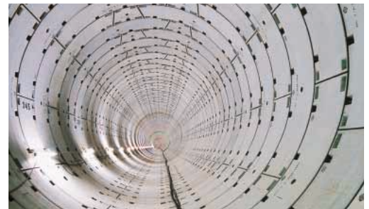
寝屋川流域下水道中央南増補幹線(一)（大阪府）
