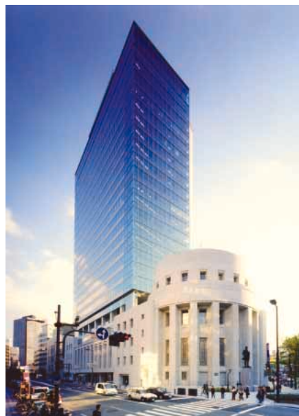
大阪証券取引所ビル全景
