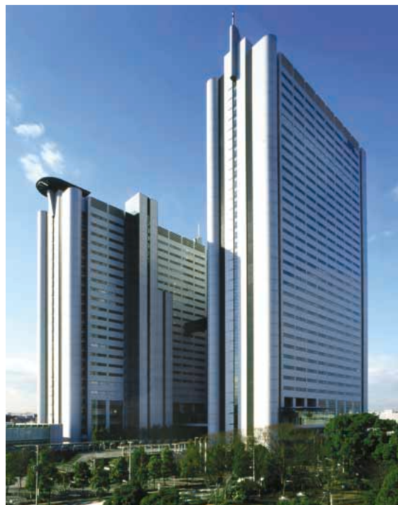
NEC 玉川ルネッサンスシティ ノースタワー・ホール(神奈川県)
