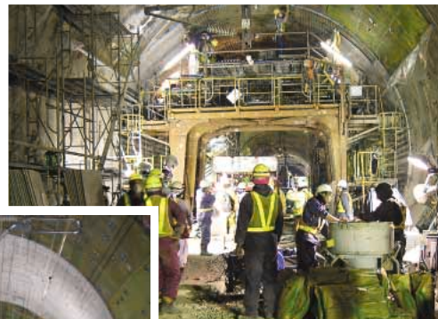
施工中の様子
