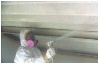
無機系飛散防止処理剤の施工風景
