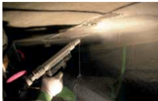
ドライアイス吹付けによるアスベストの除去作業風景
