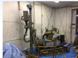
図7 注入井戸設置(建屋内)
