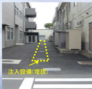
図4 注入井戸・配管類を埋設
