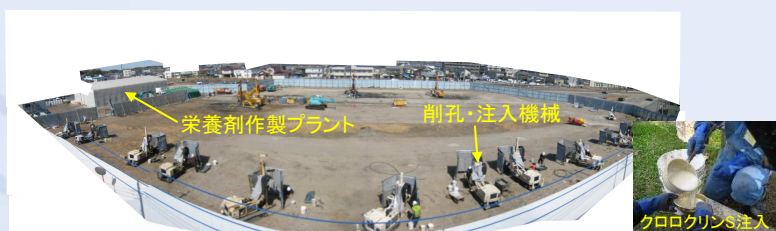
図14 クロロクリンS工法の施工状況
