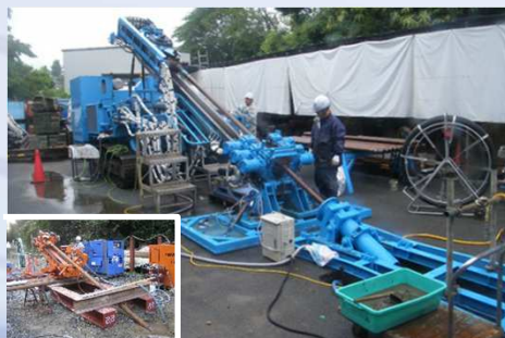
図5 ジオフレックスドリル工法の施工状況
