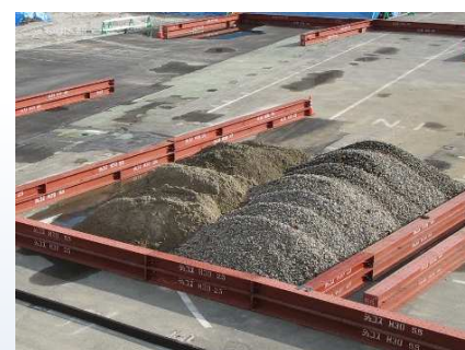
図6 処理済土の仮置き(浄化確認調査)
