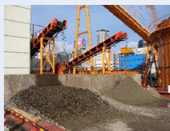
図7 駅舎跡地整備他工事での適用状況
