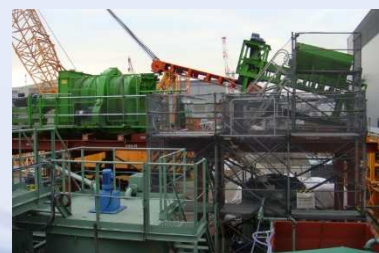
図3 掘削土破砕システムで土丹にも対応
