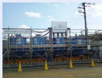
図5 泥水式シールド工事への適用事例
