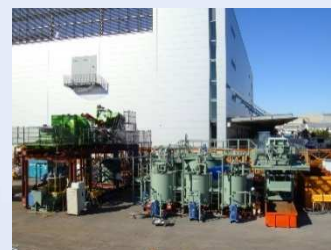
図8 掘削土(土丹)への適用事例
