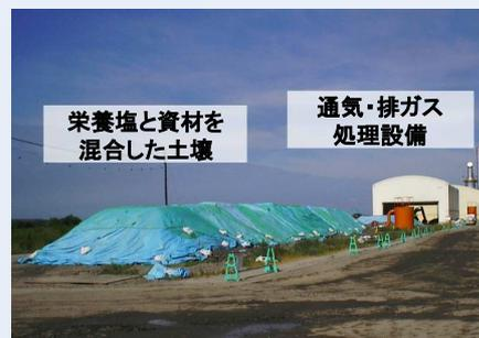
図7 バイオヒートパイル浄化工事状況
