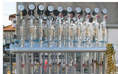
図6 送気設備(送気量制御部)
