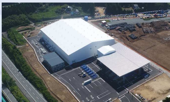
写真3 大熊3工区受入分別施設全景
