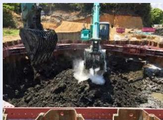
写真10 バックホウによる攪拌状況
