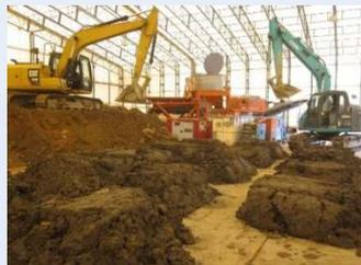
写真8 自走式土質改良装置
