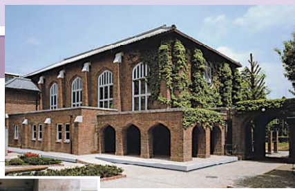
レンガ造建物に対する国内初の免震レトロフィット改修 (立教学院諸聖徒礼拝堂)
