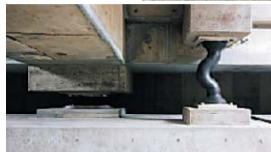
レンガ造建物に対する国内初の免震レトロフィット改修 (立教学院諸聖徒礼拝堂)
