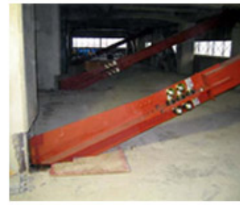
制震改修事例
