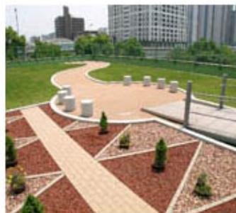
舗装の下に埋設した給水パイプと導水シートが水を拡散し、揚水ブロックが舗装表面まで水を運ぶことで、最適な湿潤路面を作ります
