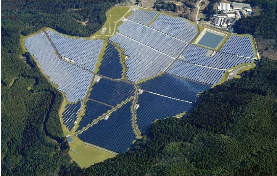
プロジェクト 01 芦北太陽光発電所
