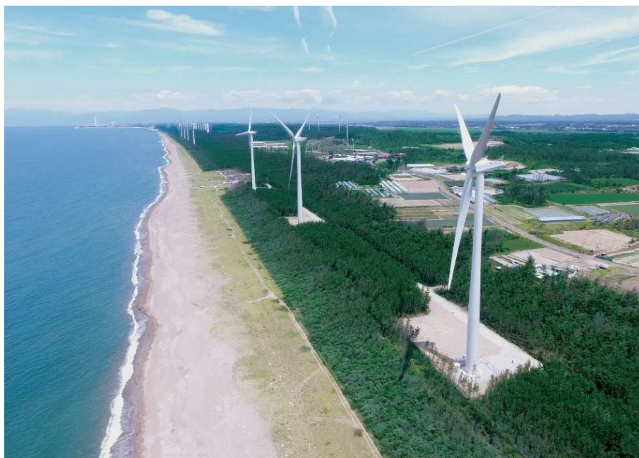
プロジェクト 04 三種浜田風力発電所
