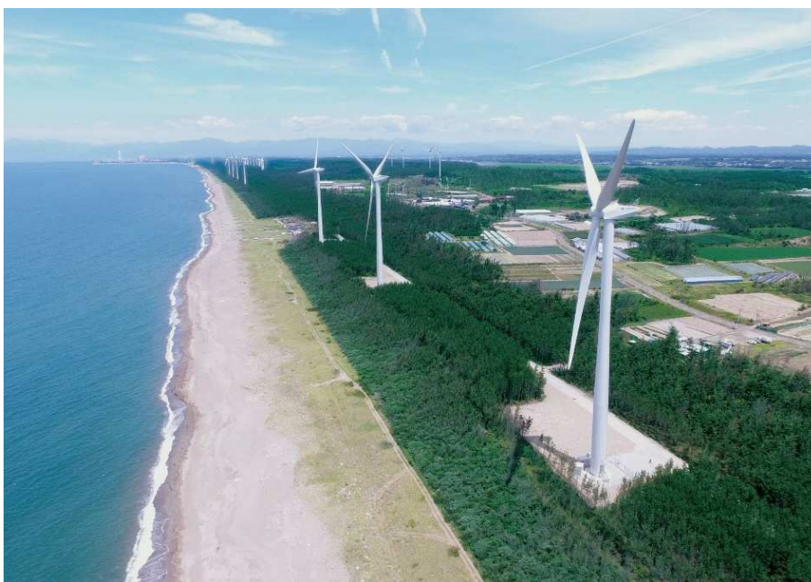
プロジェクト 04 三種浜田風力発電所
