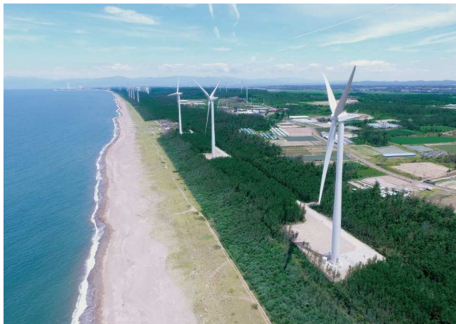
プロジェクト 04 三種浜田風力発電所
