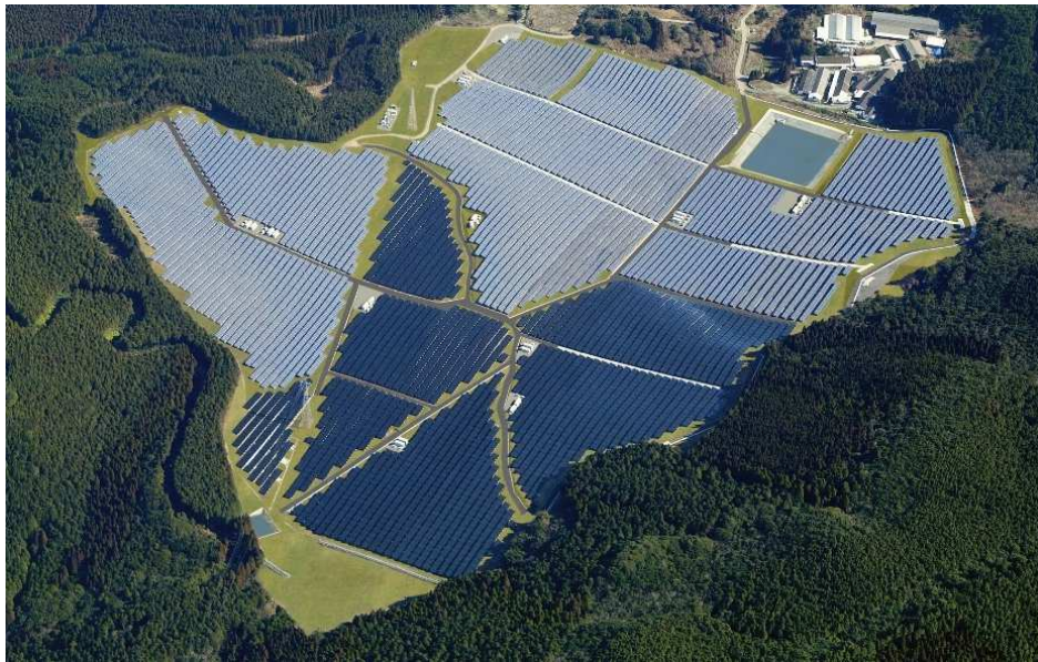
プロジェクト 01 芦北太陽光発電所
