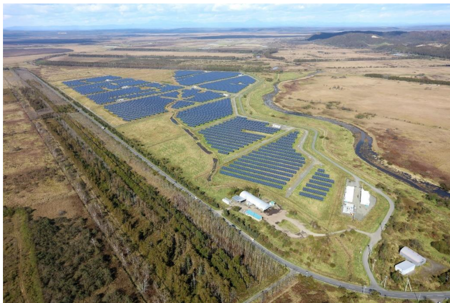
プロジェクト 02 釧路町トリトウシ原野太陽光発電所
