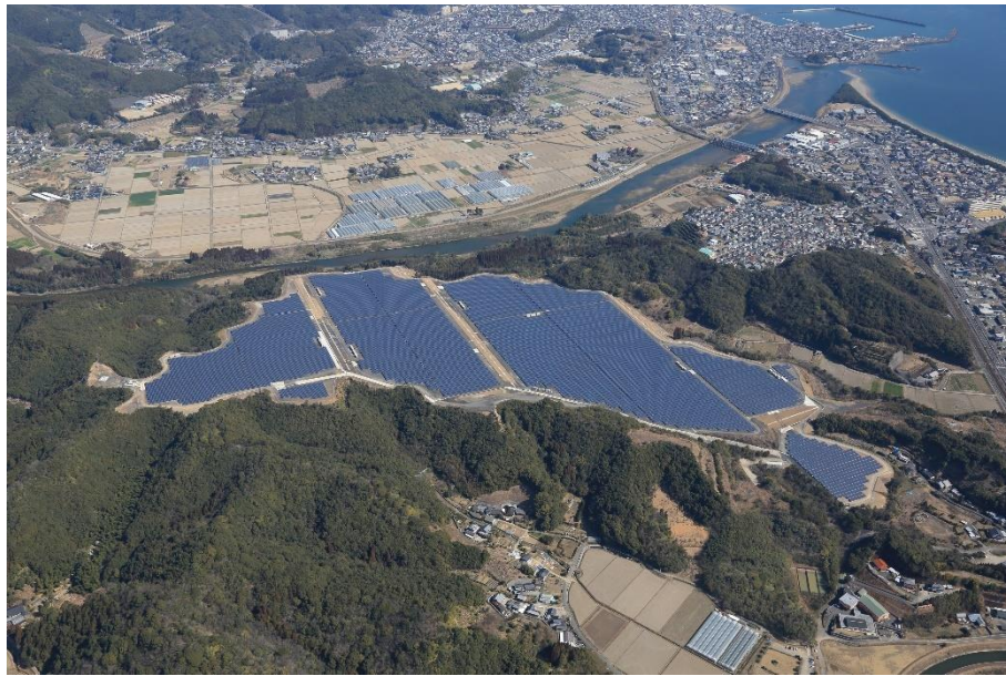
プロジェクト 03 日向日知屋太陽光発電所
