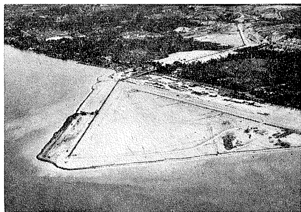
図-3 空からの埋立て現場
