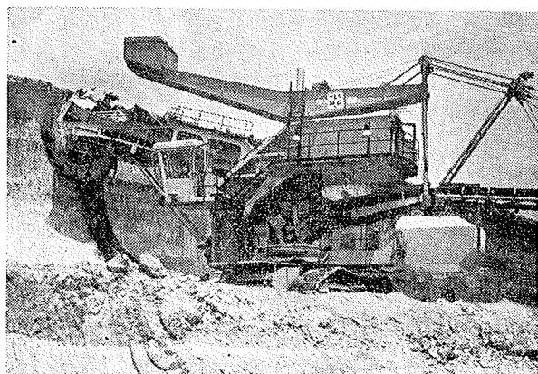
図-1 バケット・ホイールエキスカベーターによる掘削
