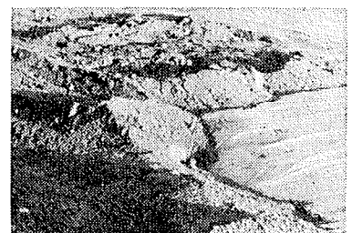
図-24 まき出し先端部に発生するシートの引張力 (福山埋立地)
