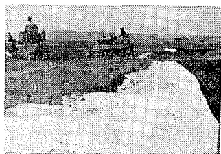
図-21 シート上の土砂まき出し状況 (福山埋立地)
