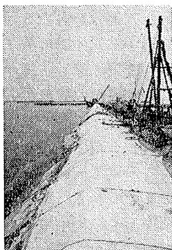
図-4 高砂岸壁保護工事状況
