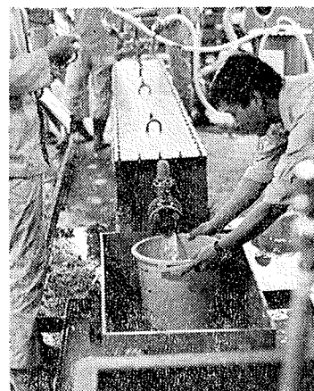
写真三 OH-GROUT 注入前の流量測定
