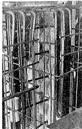
写真-9 JOF 工法による打継部
