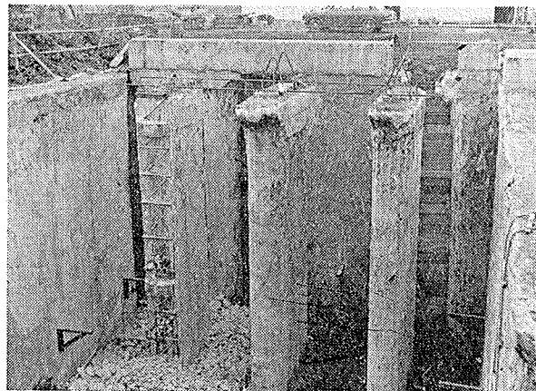
写真-2 根切り工事時の状況
