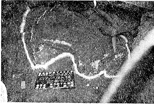
写真一 注入状況の観察結果 (切羽付近)
