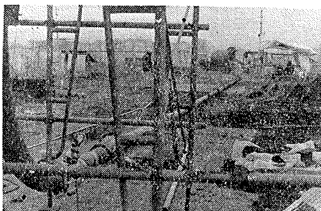
写真-1 配管の状況
