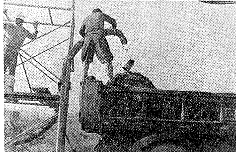
写真-2 輸送管筒先の状況
