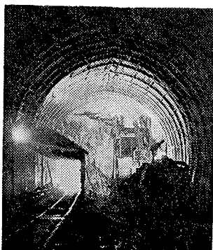
写真一1 全断面の施工
