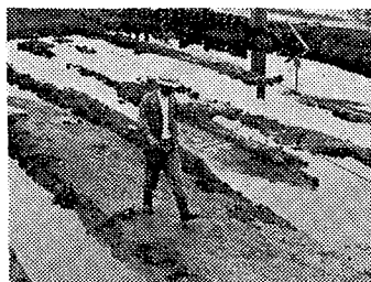
写真-4 処理後のヘドロ硬化状況 (処理3日後)
