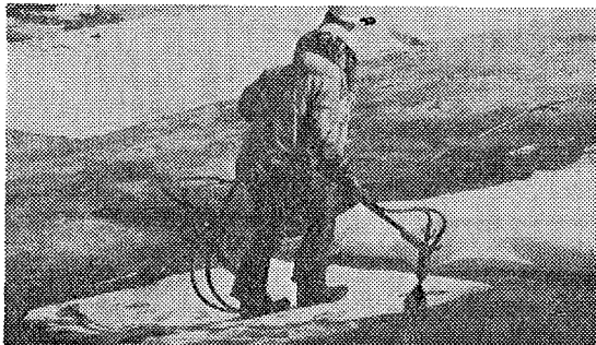
写真二 吹き付け作業状況
